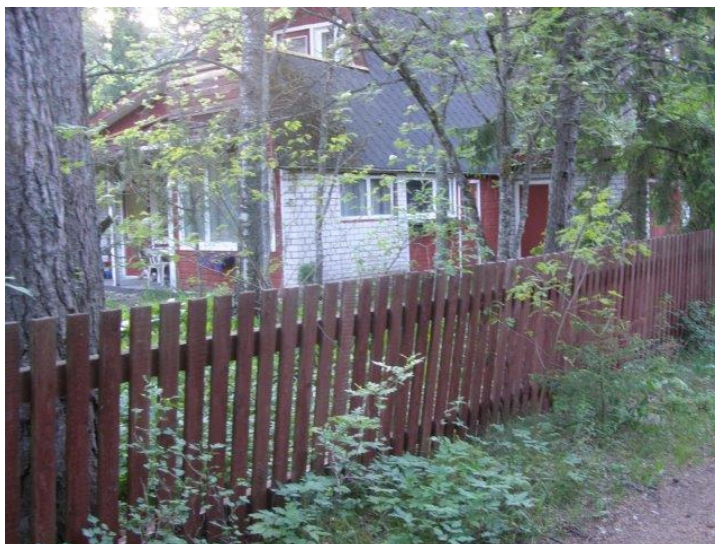
Foto 10. Vaade Muru tee 4 kinnistul paiknevale hoonele
