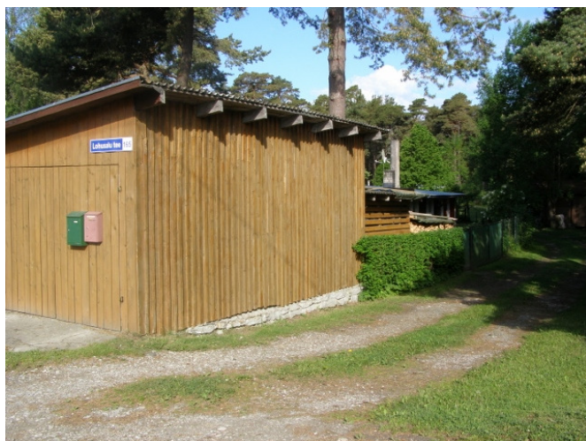
Foto 3. Vaade Lohusalu tee 165 ja 167 kinnistul paiknevatele hoonetele
