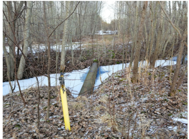
Foto 4. Vaade ala lõunaosas paiknevale kraavile ja elektrikaabli kaitsetorule
